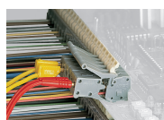
Prüfen mit Prüfsteckermodulen
