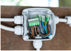
Verdrahtung in der Abzweigdose
